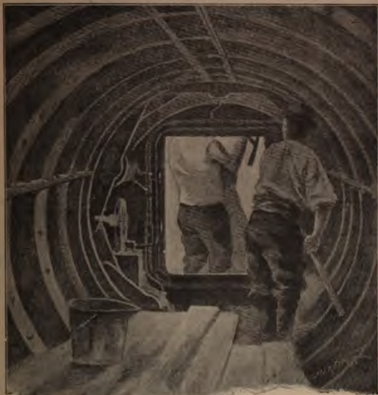
Fig. 257. — Travail dans le bouclier.
